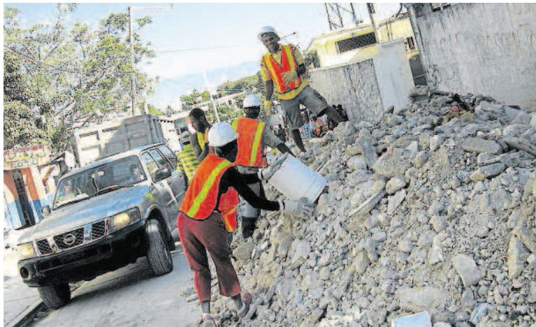
Un chantier de démolition, dans le quartier de Néréte, à Pétionville, dans la banlieue de Port-au-Prince, capitale d'Haïti.
